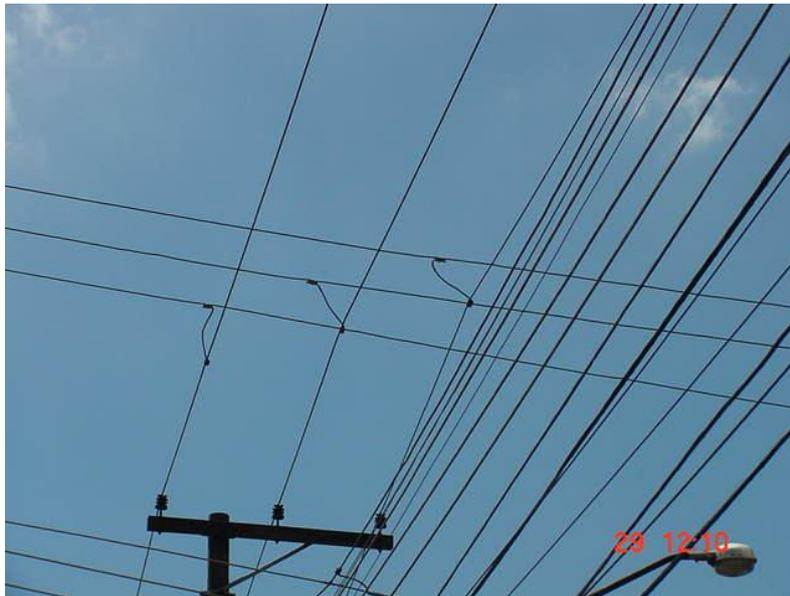
Figura 8 - Flay-tap com distância insuficiente entre fases.
